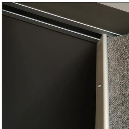
Deckenprofil eingelassen in decke
